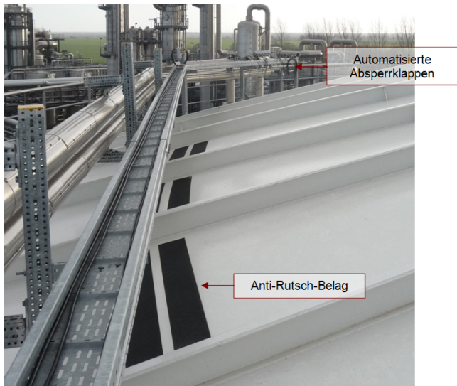
Abb. 2: Tankoberseite mit bereits installiertem Kabelkanal
