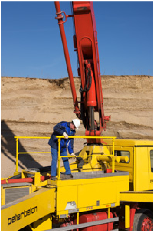
Montage der Absturzsicherung
