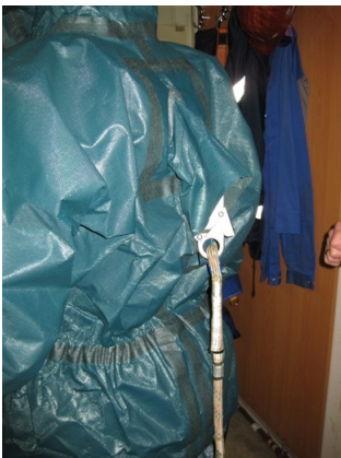
- Durchgeführtes Seil für Höhenarbeit; - Abgedichtete Durchführung der Absturzsicherung
