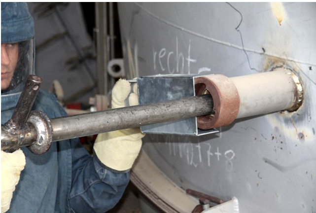
Phase 1; Ziehen, Cardoxrohr
